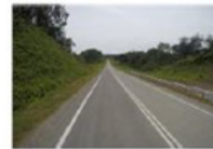
Jalan Akses Awam dari Sangan ke Sg Anap, Sarawak
