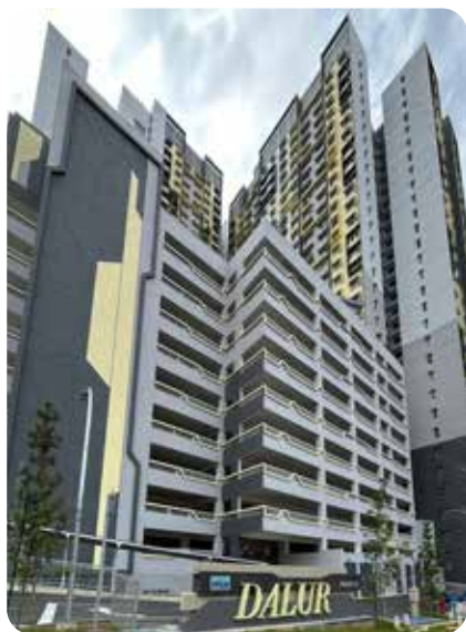
Pembangunan Perumahan Awam Malaysia (PPAM), Precinct 18 Putrajaya
