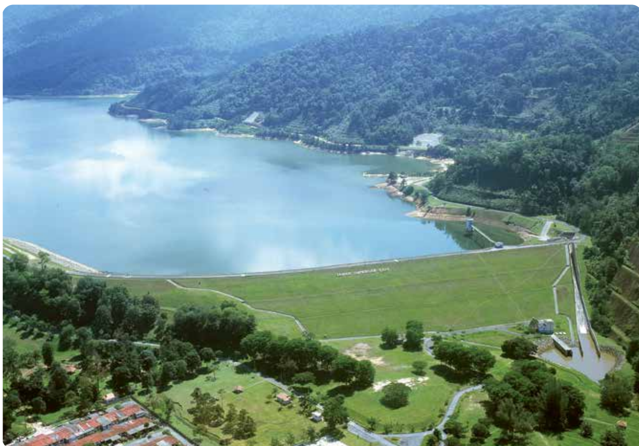
Projek Memperkukuhkan Struktur dan Fasiliti Empangan-Empangan Tebatan Banjir, Empangan Batu, Gombak, Selangor (Reka dan Bina) ("EBG"), Gombak, Selangor.
